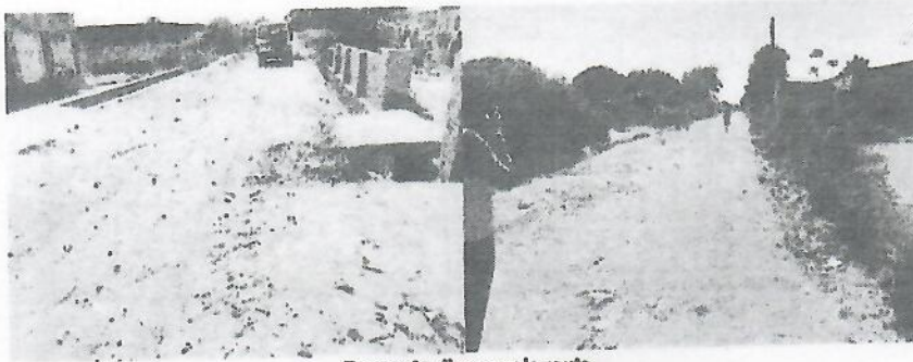
Traversée d'eau sur la route
